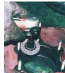
ガスケット除去後クリーニング
