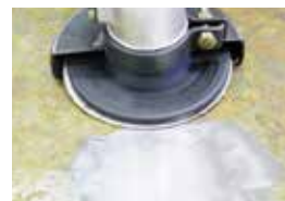
鋼板のサビ取り
