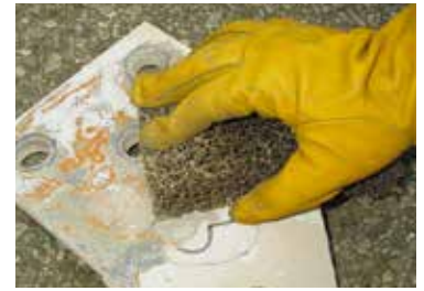
古い塗膜剥離
