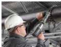
インパクトレンチを使用する場合: 12.7mm 角(sq)ドライブのもの、もしくは差込角 12.7mm(sq)のスクエアドライブアダプターをご使用ください。または、1½"のヘックスインパクト用ソケットもご利用いただけます。
