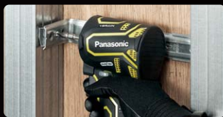
ボックス支持金具の取り付け
