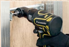
配線支持金具取り付け
