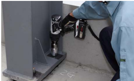
アンカーボルト締め
