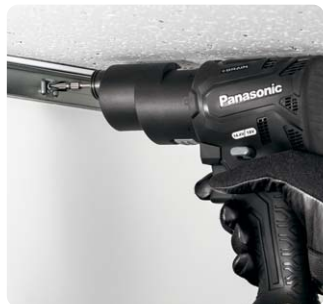
壁際のメタルモールの取り付け
