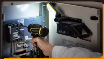
盤内作業に (マグネット取り付け)
