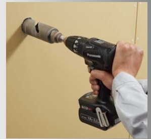
木工ホールソー穴あけ
