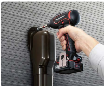
外壁へのエアコンダクト取り付け
