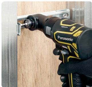
配線支持金具取り付け
