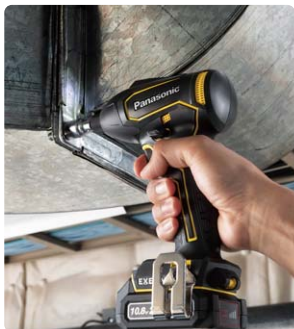
ダクト接続時のボルト締め
