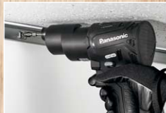
壁際のメタルモールの取り付け
