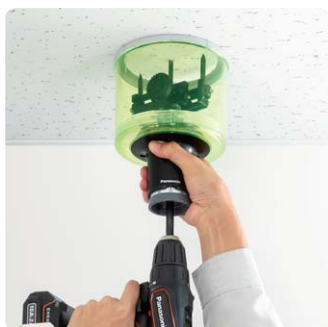
化粧ボードへのダウンライト用穴あけ (Φ100mmユニバーサルホルソー穴あけ)
