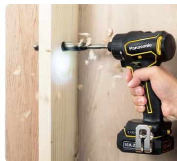
通線用の間柱への穴あけ (Φ18mm木工キリ穴あけ)
