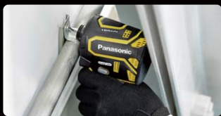
配管固定サドルの取り付け
